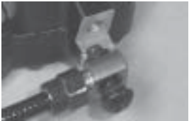
Armado de la tubería de la zapata G1
